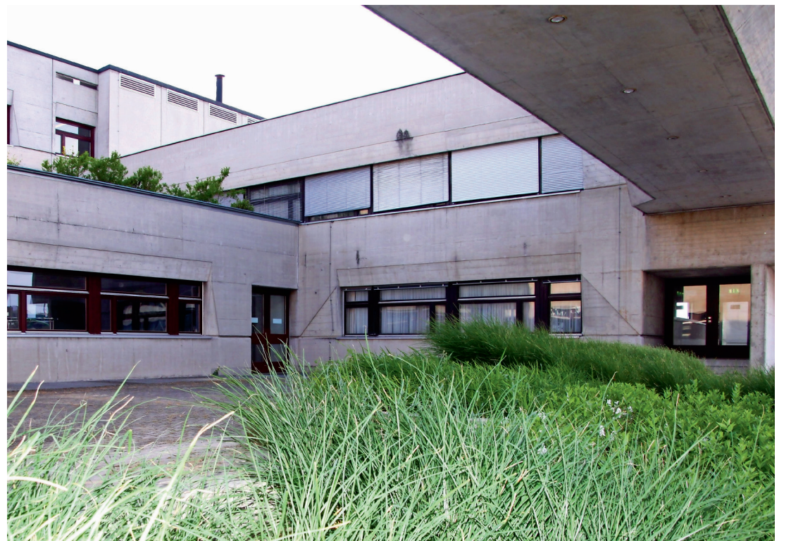
Karl Schwanzer, WIFI Lehr- und Werkstättengebäude in St. Pölten, 1965–1972, Vorhof FOTO: MANFRED SCHIMEK
