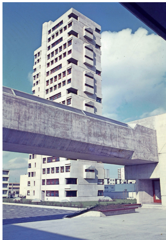
Karl Schwanzer, WIFI, Internatsturm, St. Pölten, NÖ, 1965–1972, Internatsturm 1999 abgerissen. FOTO: ARCHIV KARL SCHWANZER WIEN
